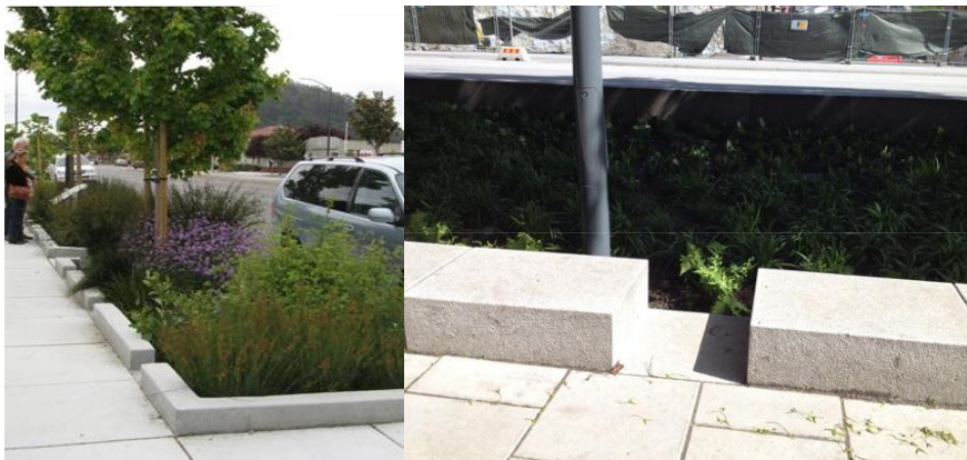
Figur 18. Inspirationsbild med nedsänkta växtbäddar och öppning i kantsten. Källa: Tengbom.
